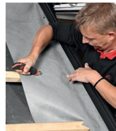
Montaż na łąkach montażowych - połączenie wodoszczelne
