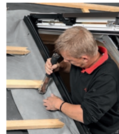
Montaż na łąkach montażowych - połączenie wodoszczelne
