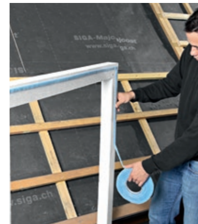
Montaż wodoszczelnej taśmy uszczelniającej
