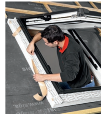
Montaż ramy MDA oraz wiatroszczelne połączenie taśmą
