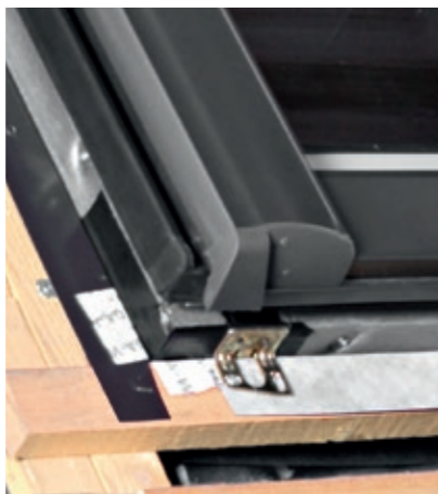
Wykonanie uszczelnienia wodoodpornej taśmą dookoła okna
